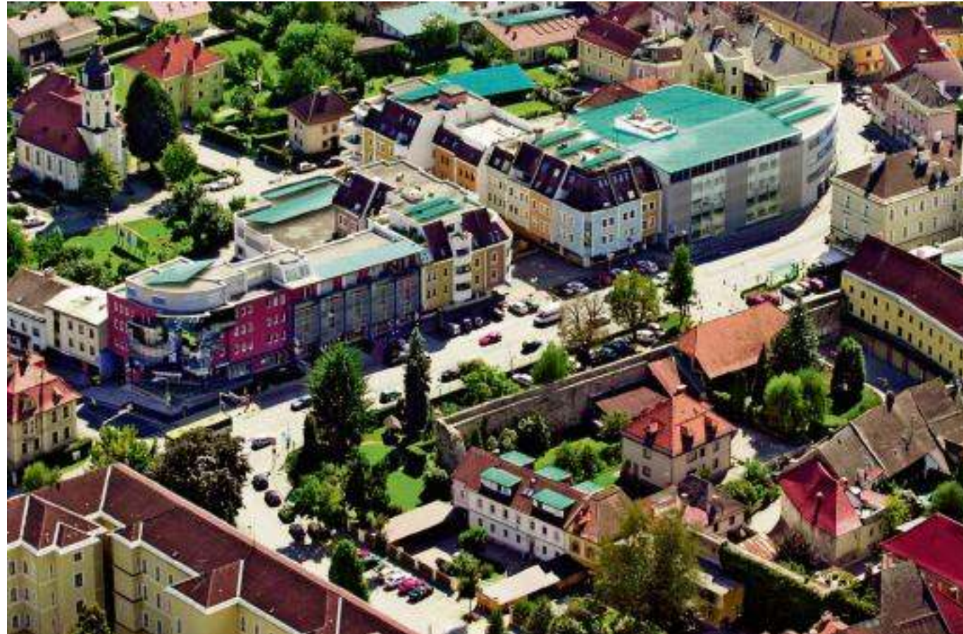
Auf den Dächern der Stadt St. Veit entsteht ein Kraftwerk: Knapp ein halbes Megawatt Strom wird es liefern PRIVAT/MALOJER BAUMANAGEMENT
