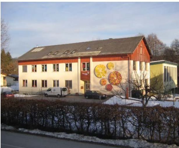
Die Volksschule vor der Sanierung
