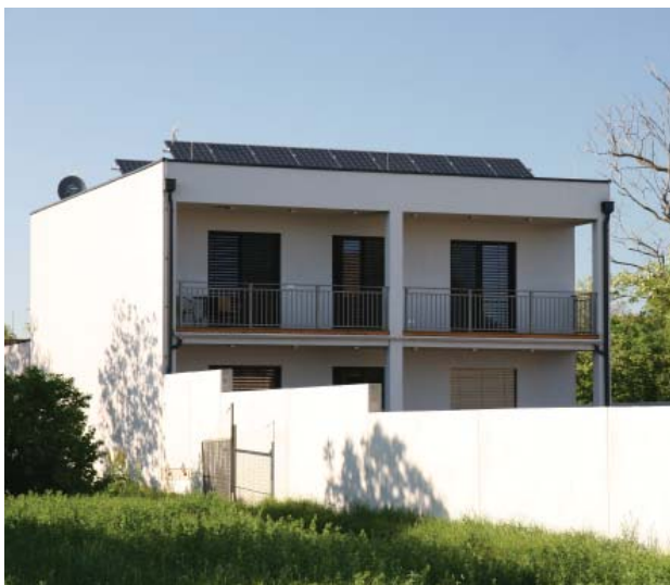
Das Plusenergiehaus nach Fertigstellung und Installation der 7,2kWp Photovoltaikanlage
