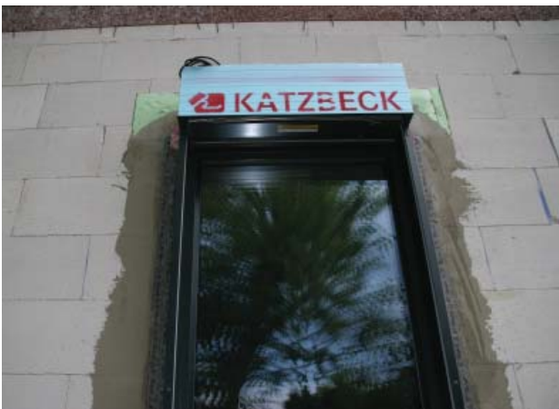
Bündig mit der Fassade eingebaute Fenster mit Dichtbändern und Dämmung hinter den Raffstorkästen
