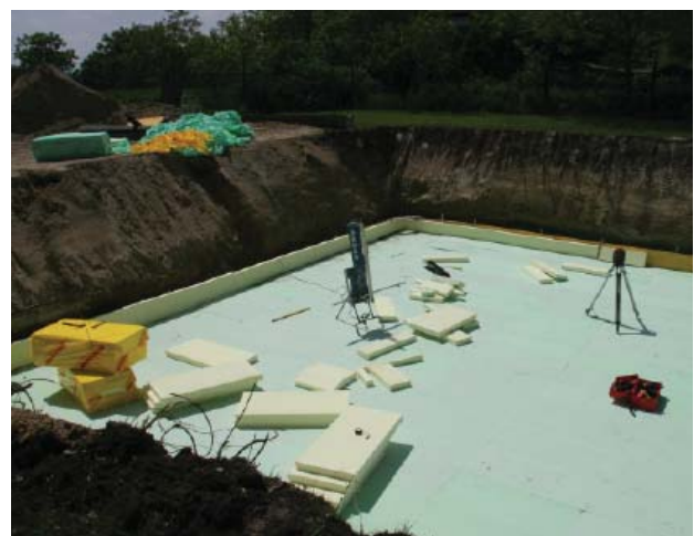
16 cm XPS-Dämmung unter der Fundamentplatte
