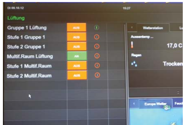
„Leitstelle“ für die Steuerung der Haustechnik
