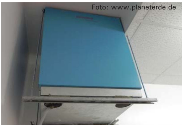
Komfortlüftungsanlage mit Wärmerückgewinnung
