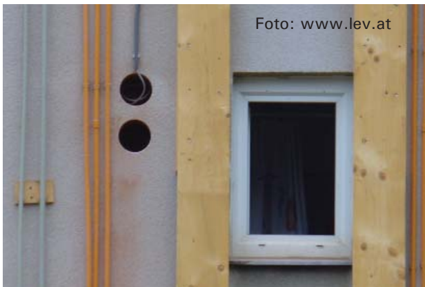
Bohrungen für die dezentrale Wohnraum-Komfortlüftung
