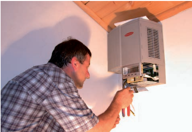
Montage eines Wechselrichters
