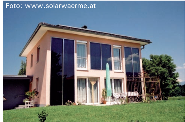
Integration der Solaranlage in die Fassade des Gebäudes
