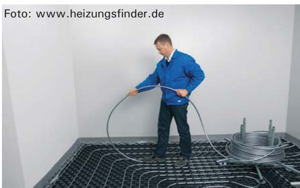
Verlegung einer Fußbodenheizung mit Noppensystem
