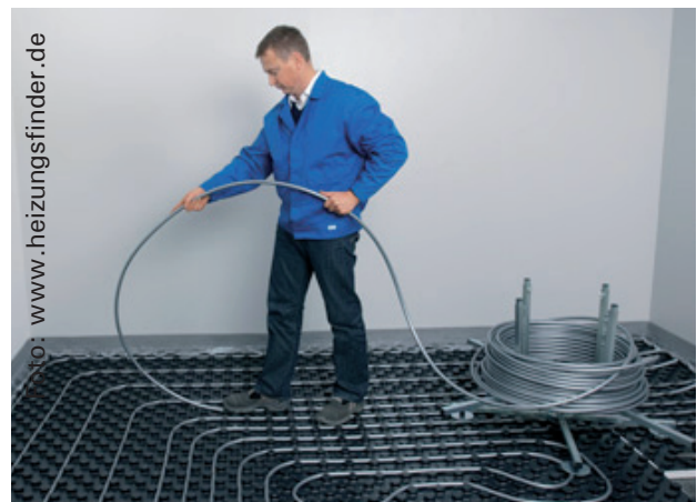
Verlegung einer Fußbodenheizung
