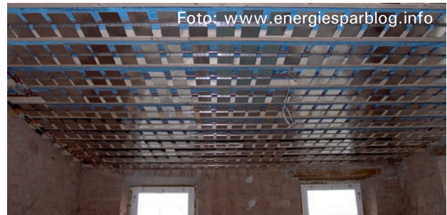
Verlegung einer Deckenheizung
