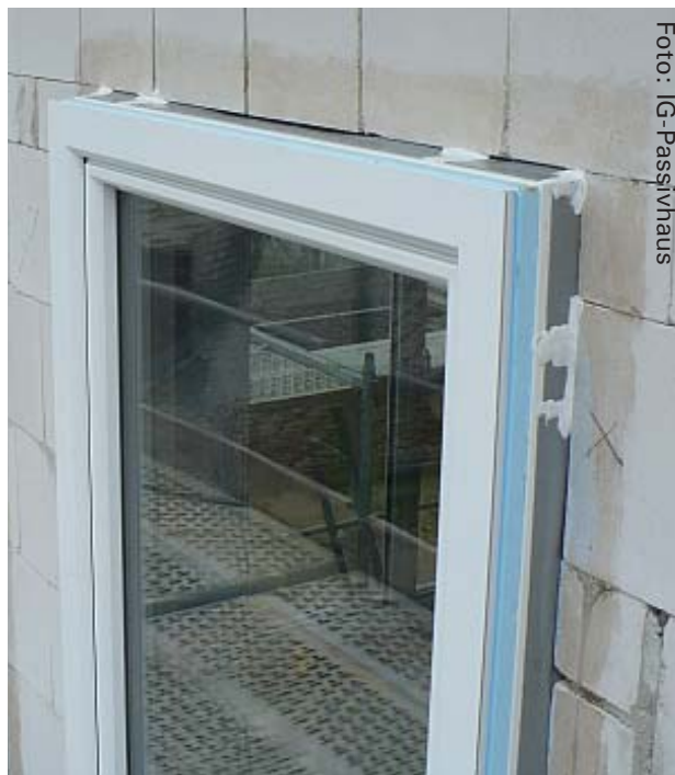
Positionierung des Fensters bei starker Dämmung
