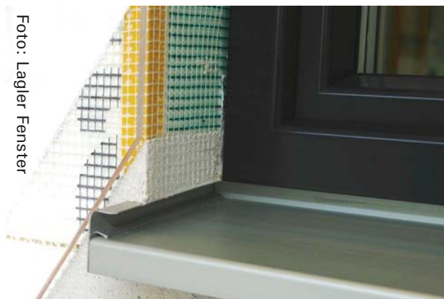
Dämmung der Fensterlaibung
