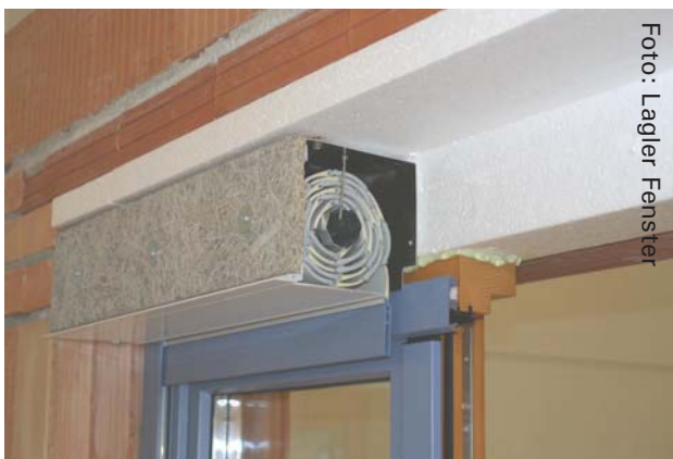
Wärmebrückenfreier Einbau eines Rollladens.
