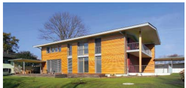
Holzmassivbauweise (Fotos www.KLH.at )
